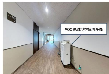
実証の様子 上から動物病院診察室、動物病院廊下
